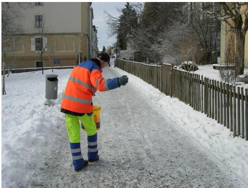
Photo 3 - Epandage à la main
